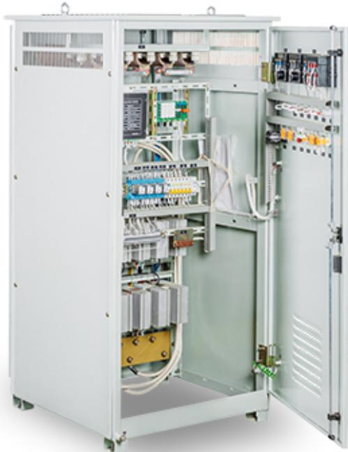
Тиристорные возбудители ВТЕ-11 и ВТЕ-14 с аналоговым управлением предназначены для питания обмотки возбуждения и управления током возбуждения синхронного двигателя при прямом или реакторном пуске от сети.
